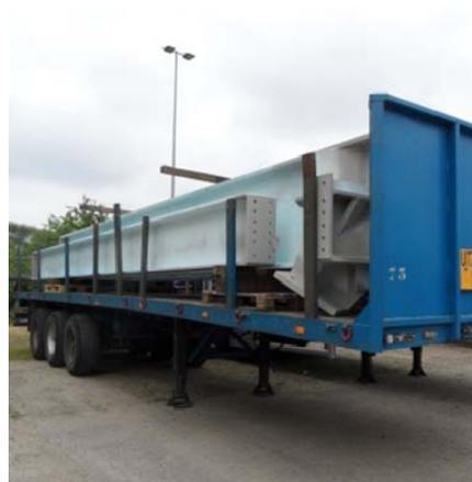
写真⑥ 工場から建築現場への輸送状況
