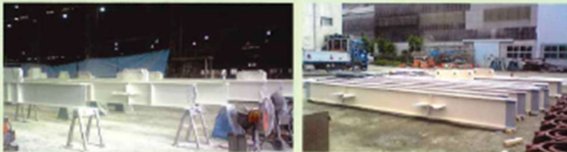
●塗装作業 ●工場塗装の例
